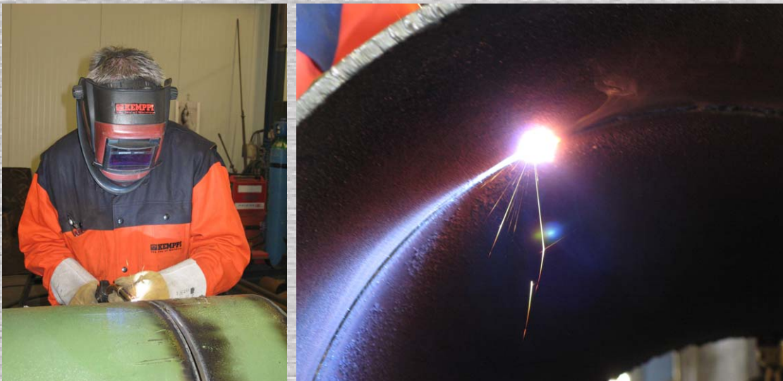
Figuur 3: X-60 pijpleiding gelast met Fast Root
