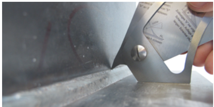
Visuele inspectie van lassen: opmeten van de keeldoorsnede van een hoeklas
