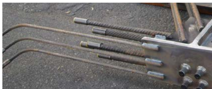
Assemblages soudés entre les aciers d'armature et de construction
